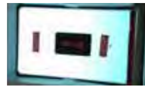
Botola manuale che funge da uscita di sicurezza.
